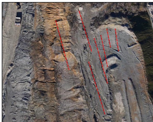
Sl. 3. Registrovane tenzione pukotine na površini terena u severoistočnoj zoni površinskog kopa
