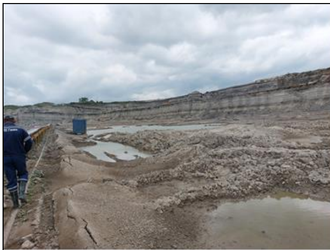
Sl. 4. Pojava voda - koje teku ili se zadržavaju nekontrolisano, samim tim oštećuju etaže i smanjuju stabilnost istih (2024. godine)
