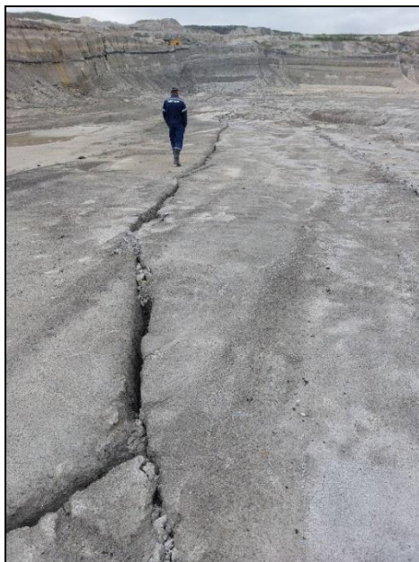
Sl. 5. Pukotine na etaži - potencijalne klizne ravni (2024. godine)
