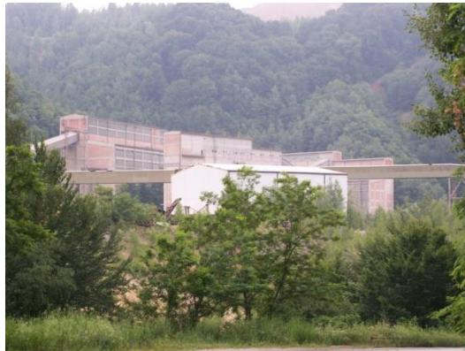
Slika 3. Objekti sekundarnog i tercijernog drobljenja i prosejavanja RBM-a „Staro rudno drobljenje“
