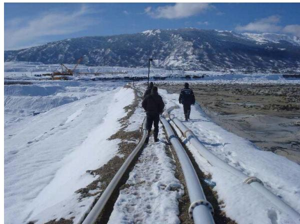
*Slika 12 – HDP cevovodi za hidrotransport pulpe od postrojenja za pripremu pepela do aktivne Kasete II*
