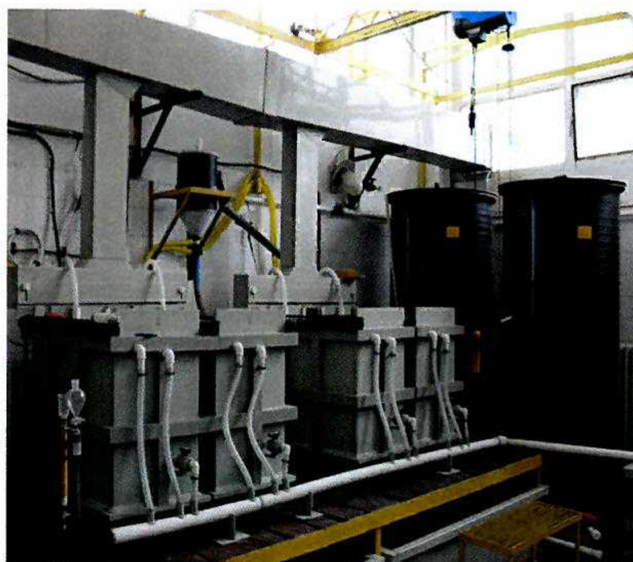
Slika 1. Poluindustrijsko postrojenje za elektrolitičku preradu bakara, mesinga i srebra – Linija II
