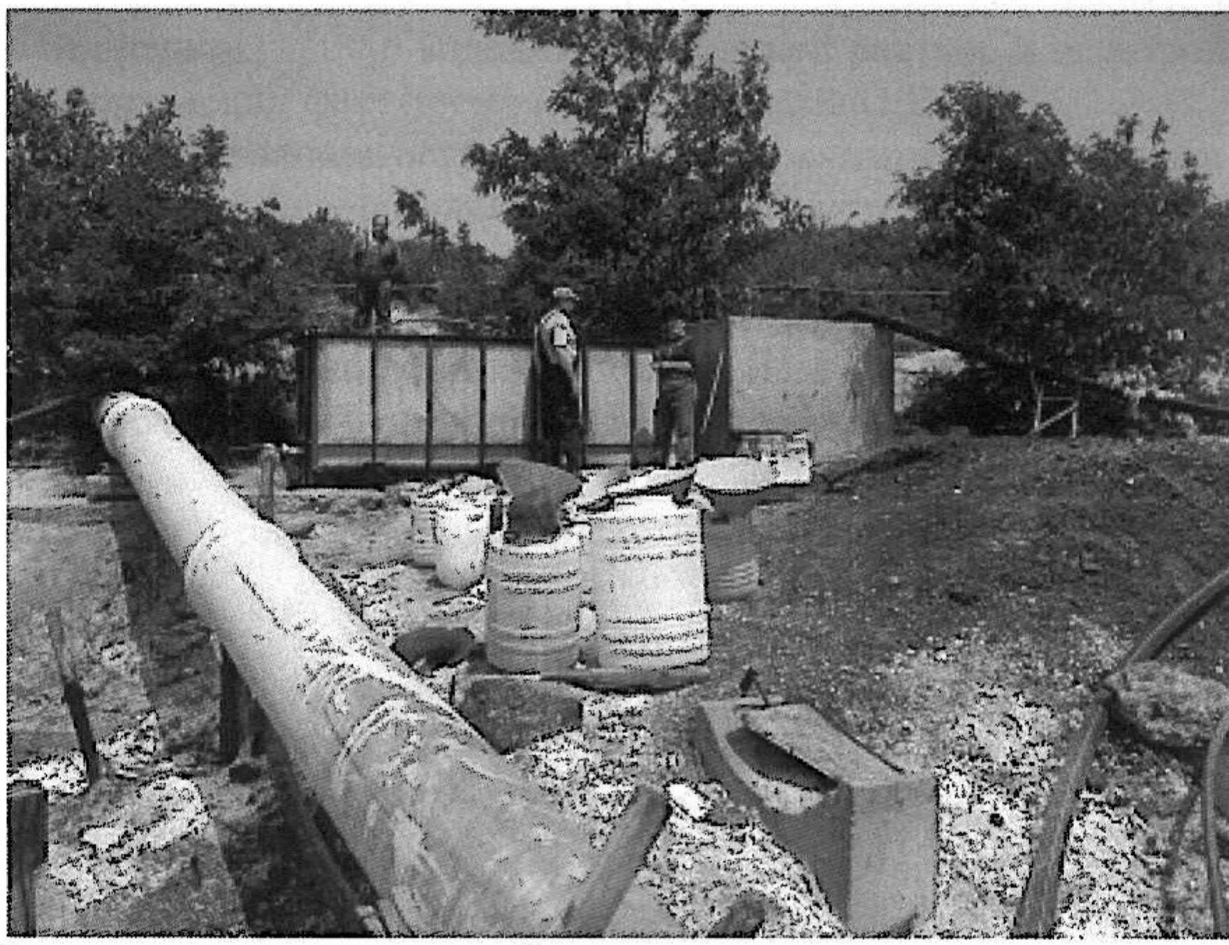
Слика 2. Резервоари за прихватање бакроносних рударских растворова и колективну хидроксидну преципитацију бакра вожђа и примеса
