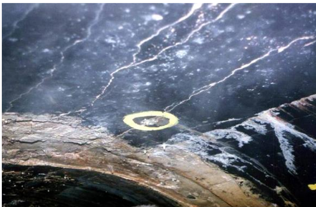
Slika 5. Pukotine na svodu kolektora na deonici ispod brane
