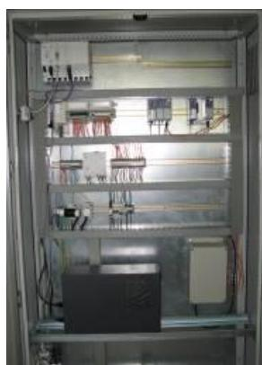
Sl. 7. PLC, I/O moduli i oprema za optičku komunikaciju u kontrolnom centru
