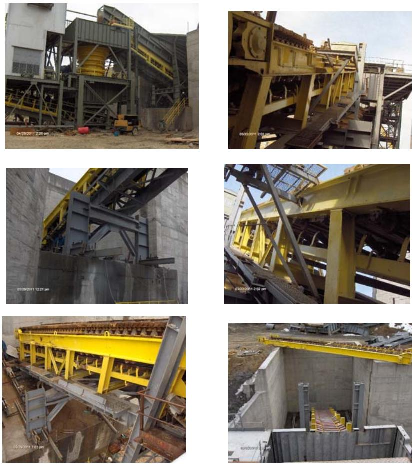
**Fig. 4.** Phases of assembling the apron feeder člankastog dodavača
