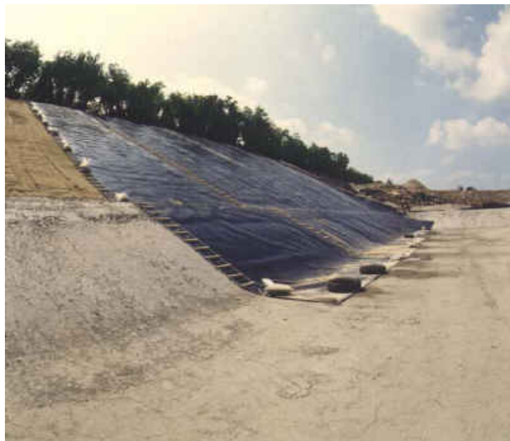
Sl. 1. Detalj polaganja vodonepropusne folije na unutrašnju kosinu brane
