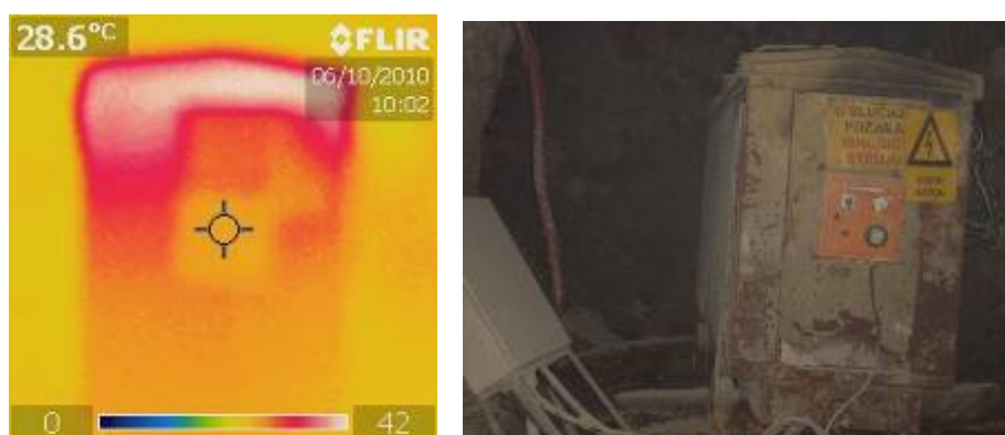
Slika 4. Termovizijski snimak i standardna fotografija rudničkog transformatora
