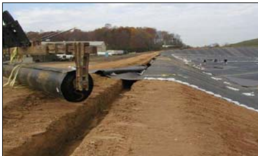
Sl. 4. Zatezanje geomembrane pomoću zateznog rova i zemlje
