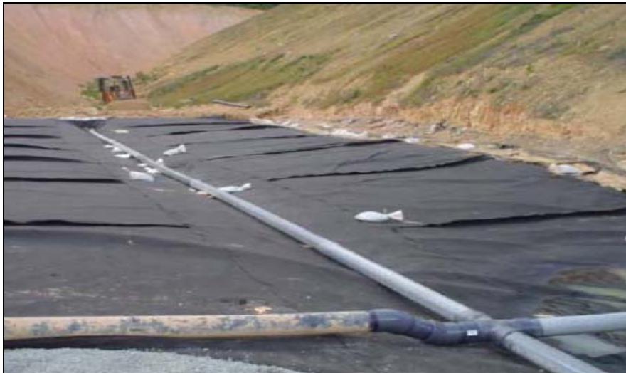
SI. 5. Polaganje drenažnih cevi po dnu deponije
