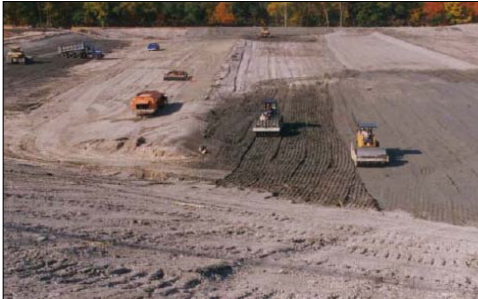
Sl. 1. Planiranje, kompaktiranje i ravnanje dna deponije
