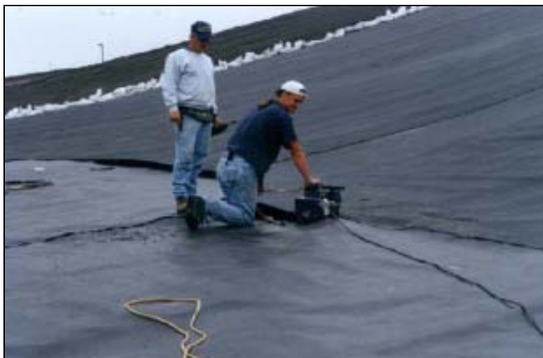
Sl. 3. Detalj spajanja HDPE geomembrane
