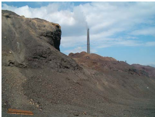
Sl. 1. Subvertikalni odsek kosine na „depo šljake 1“
