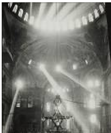
Sl. 1. Hagia-Sophia (Sveta Mudrost), crkva iz VI veka, zadužbina imperatora Justinijana, u kojoj je na više mesta primenjena konstrukcija pandantifa i formiranje tambura sa prozorskim otvorima omogućavajući osvetljenje
