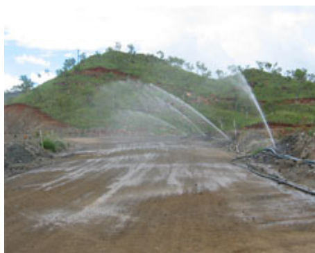
Slika 3. Sistem prskalica na kopovima
