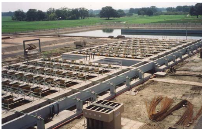
Slika 2. Izgled anaerobnog postrojenja za prečišćavanje industrijskih otpadnih voda u primeni (Mirzapur)
